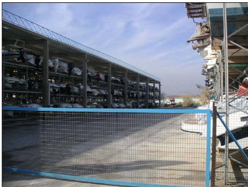
Stockage sur racks
