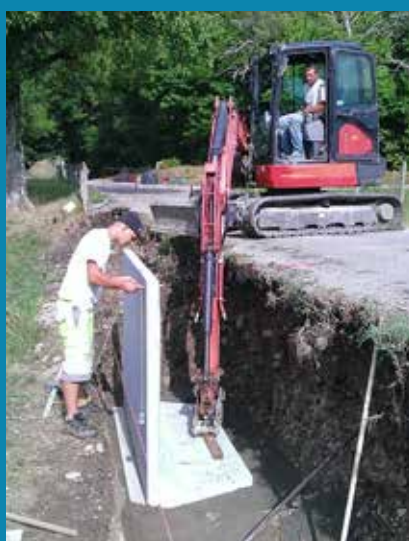
Route de la Roche (partie basse) : reprise de l'accotement de la route qui s'effondrait par un mur de soutènement et pose d'une glissière de sécurité pour la sécurisation des automobilistes.
