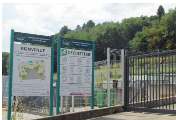
La déchetterie de la Plaisse a bénéficié de travaux de réhabilitation et de modernisation entre septembre et décembre 2016 (mise aux normes des garde-corps du quai principal, du système de vidange au niveau des bennes, aménagement d'un abri de stockage des déchets spéciaux)
