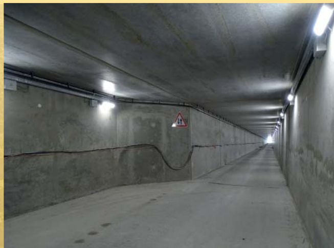
Achèvement de la galerie de sécurité du tunnel
