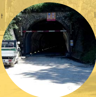
Mise en place des tôles d'aluminium sur les 1500 m de longueur
