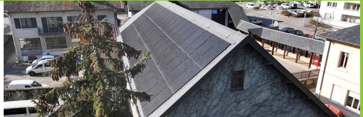
▲ 54 panneaux photovoltaïques sur une surface de 100 m<sup>2</sup> ont été directement intégrés à la toiture lors de la rénovation du Cinélaç. La production électrique de 18 000 Kw équivaut à la consommation annuelle combinée de l'école de la Cascade et de l'Espace Chantal Gambut
