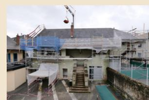
Après une première phase entamée l'année dernière (remplacement de la couverture en ardoise, déconstruction des 2 cheminées devenues obsolètes, implantation de 54 modules photovoltaïques sur la toiture...), la réhabilitation du Cinélaç se poursuit en 2023 avec une nouvelle série de travaux qui se déroulera du 27 février jusqu'à fin juin.
