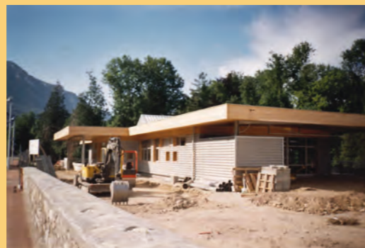
Lors des travaux d'extension en 2014
